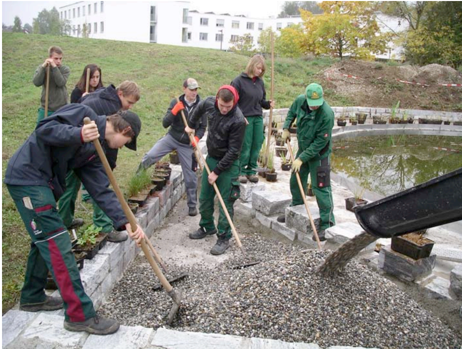
Bild: Herbst 2012, Einbringen von Kies in die Sumpfzone, anschließend Verteilung der Pflanztöpfe
