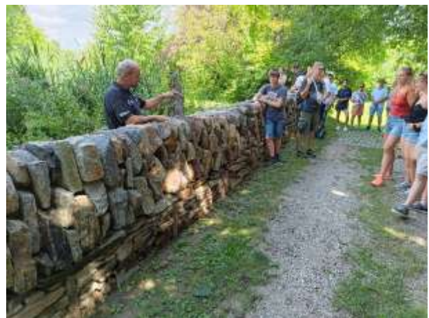
Bild 10: Herr Schieder erklärt die Bauweise der Natursteinmauer
