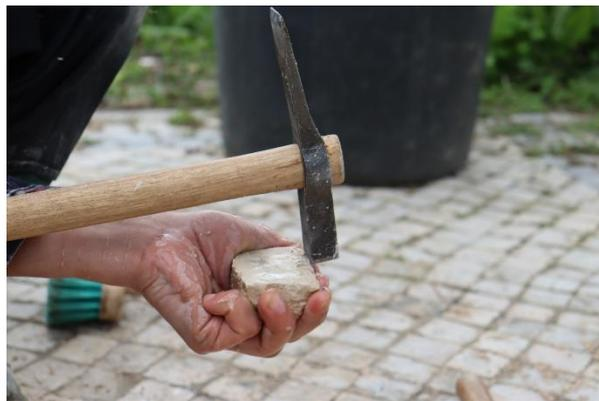
Das Zuschlagen eines Steins mit einem speziellen Pflasterhammer (martelo de pena)
